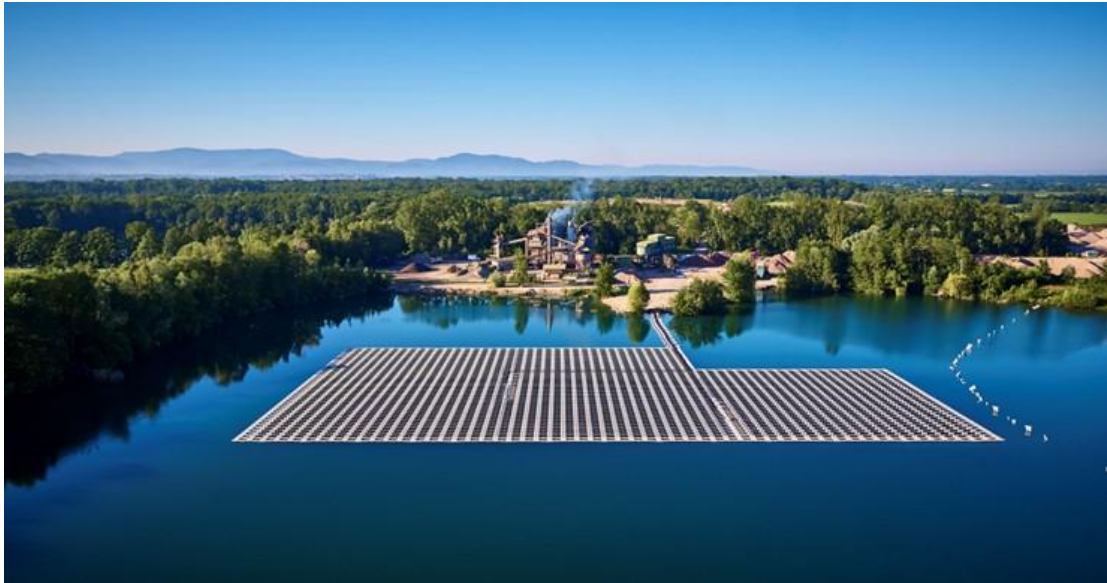
Abbildung 1: Schwimmende PV-Anlage in Renchen
